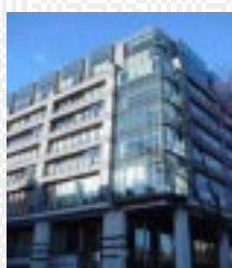
Centrum Gieldowe Warszawa
